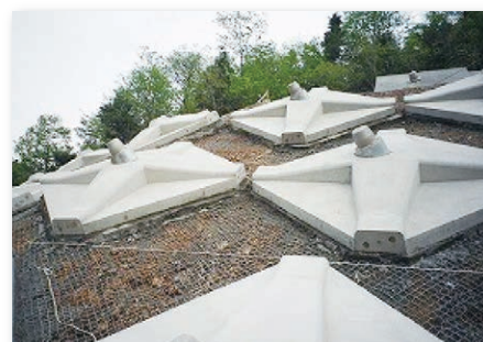
背面不陸をモルタルで調整し、安全・確実な施工を行いました。
