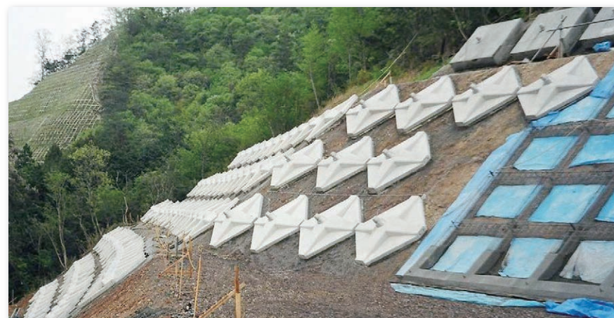
EPSSq型(兵庫県)施工風景 複合角度20°超 PUC受圧板とEPSSq型が配置された施工現場
