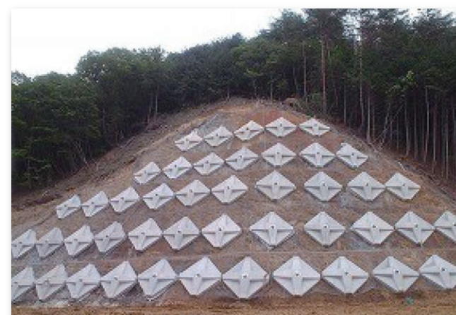
EPSSm型(兵庫県)施工全景 EPSSm300-100-10(上)
