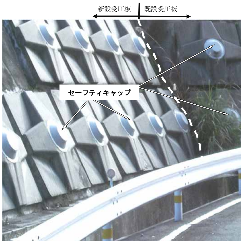
写真-6 セーフティキャップの取付状況
