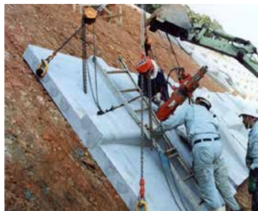
写真－1 専用吊り具を用いた施工事例
