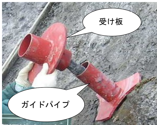
写真-3 セットパイプの設置
