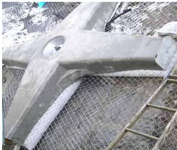
写真-5 受圧板の固定
