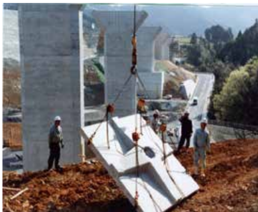
写真－1 専用吊り具を用いた施工事例
