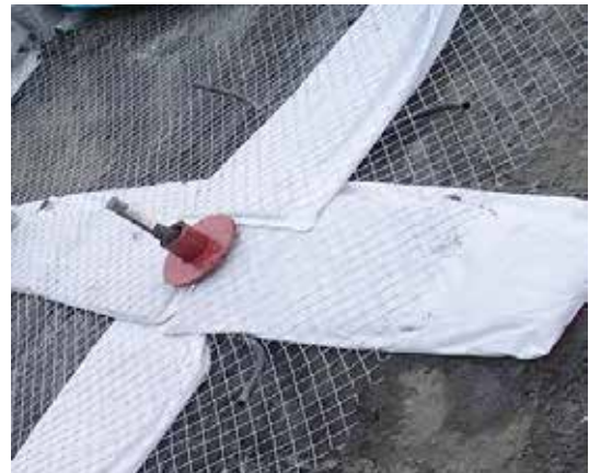
写真-4 ざぶとん材の設置
